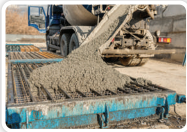
Abb. 7 Herstellung der Grundmauer aus Stahlbeton
